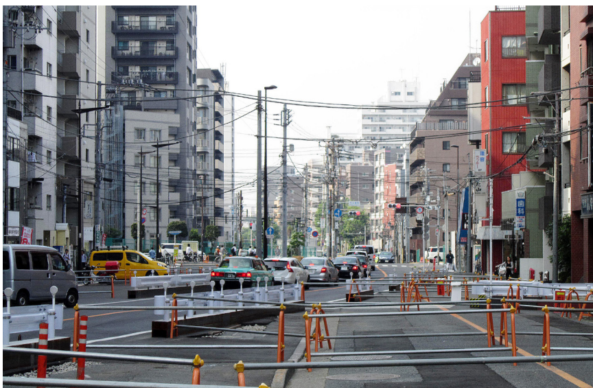
整備が進む環状第3号線(外苑東通り)
