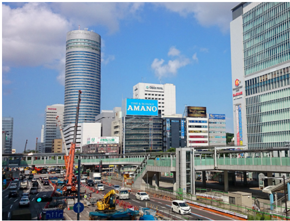
駅周辺の総合的な整備の事例（横浜市新横浜駅）
