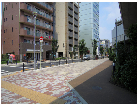
駅舎の改修を契機とした歩行環境の整備の事例 (武蔵野市武蔵境駅周辺)
