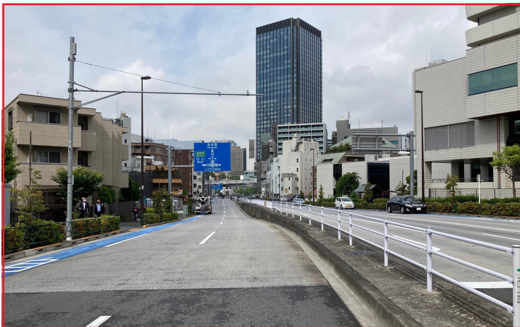
整備が完了した放射第25号線
