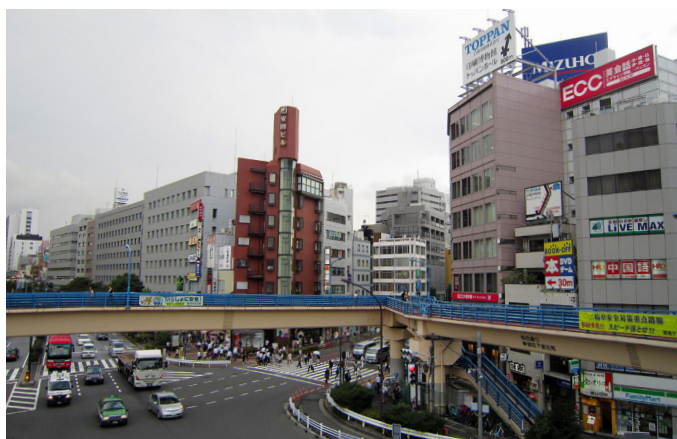
多くの人が利用する飯田橋駅東口周辺
