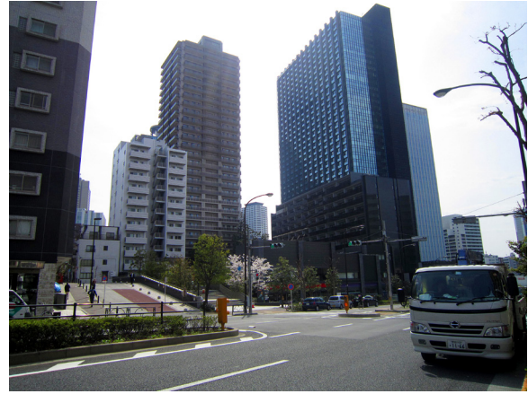
道路整備にあわせた沿道建物の不燃化の事例(北新宿二丁目)
