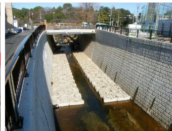
妙正寺川の護岸改修
