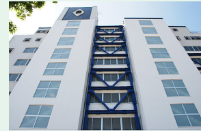
マンションの耐震改修工事の事例
