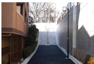
改修した擁壁(写真右側)
