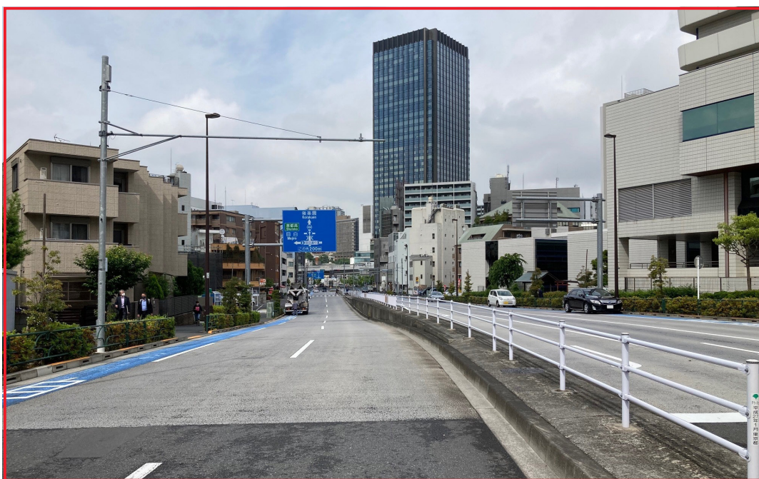
整備が完了した放射第25号線
