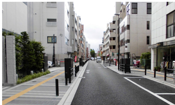
道路の無電柱化の事例(三栄通り)
