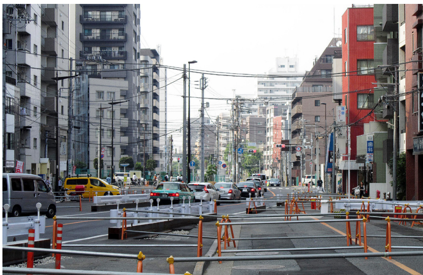
整備が進む環状第3号線(外苑東通り)
