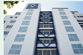
マンションの耐震改修工事の事例
