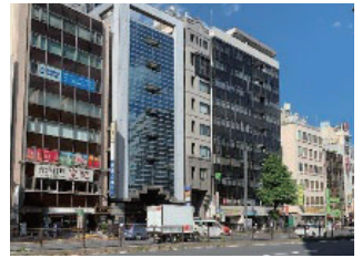
【1-4 四谷新宿通りエリア】 四谷地域の中心を貫く尾根道
