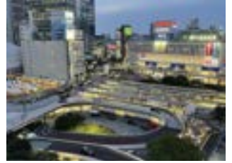
【10-3 新宿駅西口エリア】 立体的な景観の魅力をもつ立体交差
