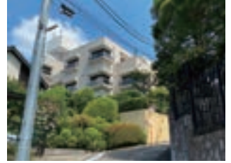
【7-3 下落合斜面地エリア】 斜面緑地を右に左に曲がる坂道
