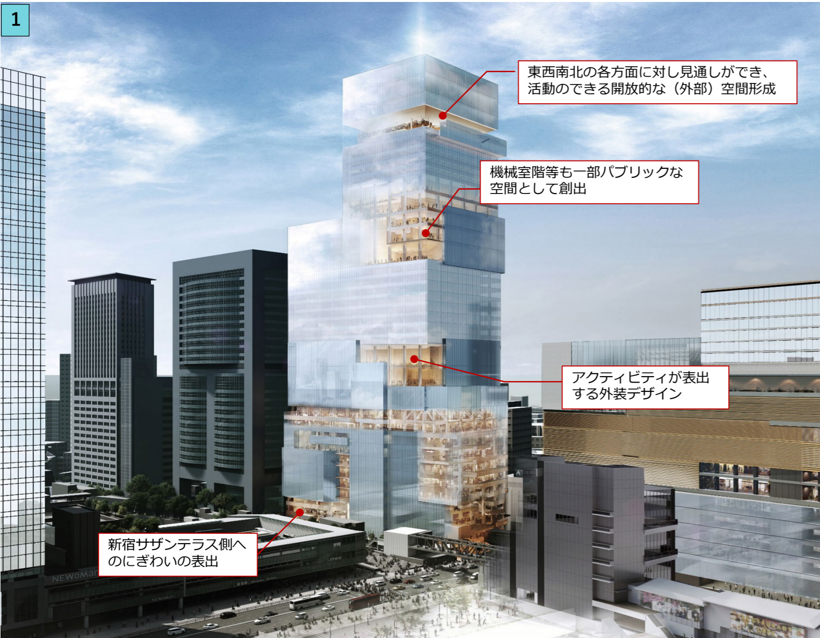
東側から望む（代々木側のランドマークとなる高層部）
