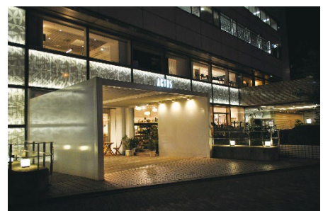
鉛直面の明るさを効果的に活用した エントランス
