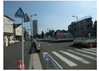
【4-4 余丁町エリア】 整備された台地上のまちなみ
