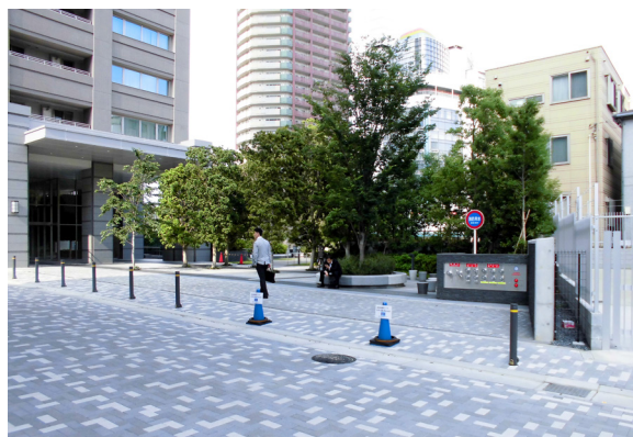
オープンスペース ※ と消防水利 ※ の確保の事例 （西富久地区市街地再開発事業 ※ ）
