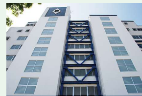
マンションの耐震改修工事の事例
