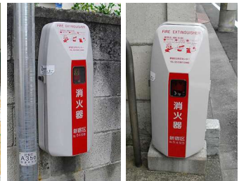
消火器の設置例
