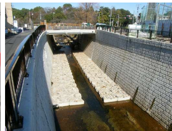
妙正寺川の護岸改修
