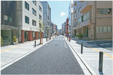
▲無電柱化した道路(道路の無電柱化整備)
