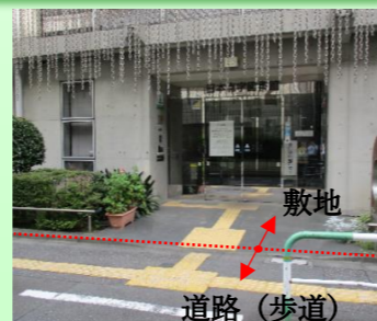
▲誘導用ブロックの連続設置
