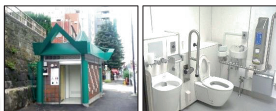
多機能トイレの設置(富久町公衆便所)
