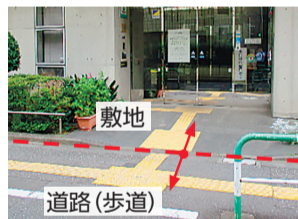
▲道路と敷地内の施設出入口まで、素材・色などが統一された誘導用ブロックの連続設置を推進
