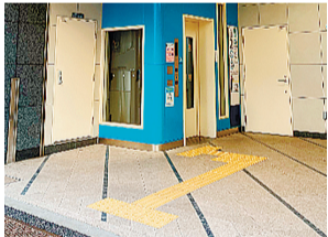
▲鉄道駅のエレベーター整備によりバリアフリールート の複数化・最短化を推進
