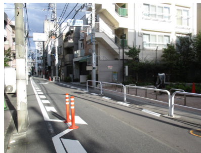
◎狭さくなどの路面表示やポストコーンによる安全対策を実施し、歩行者の安全性に配慮している
