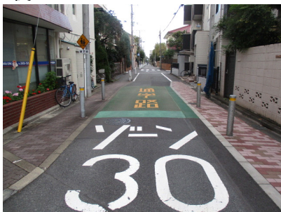
◎ゾーン30による交通規制などの安全対策と連携した道路整備(狭さくや路側帯の拡幅、カラー化など)を進める
