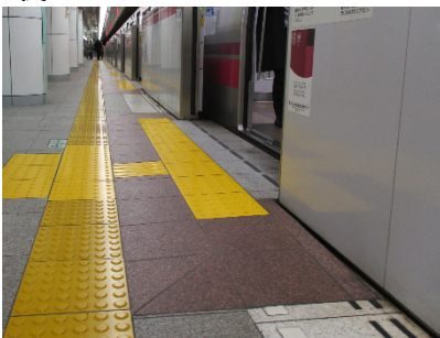
◎ホームの一部かさ上げにより車両との段差を解消している
