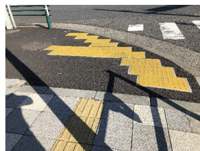
△区道と都道の管理区域境界で、誘導用ブロックが連続して設置されていない
