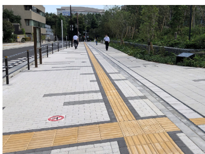
◎誘導用ブロックの両脇に縁取りをすることで、わかりやすくなっている
