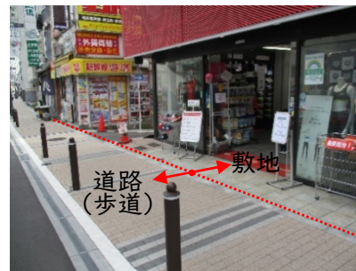
◎道路整備により、敷地と道路の段差解消がされている
