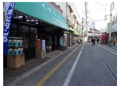
★歩行空間が狭い場合は、規格の半分の幅の誘導用ブロック（2列・15cm）による視覚障害者の誘導を検討する（区外の例）
