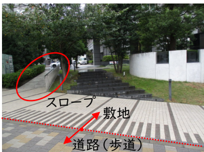
◎道路と高低差のある敷地で、敷地内に緩やかなスロープを設けている
