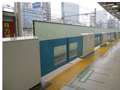
◎ホームドアを整備している
