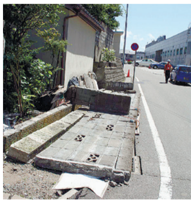
▲ブロック塀倒壊の例(平成19年新潟県中越沖地震)/提供:消防科学総合センター
