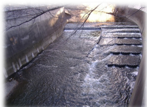
高戸橋付近の魚道（右側部分）
