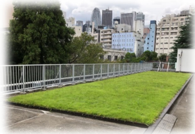
区役所第二分庁舎分館 屋上緑化
