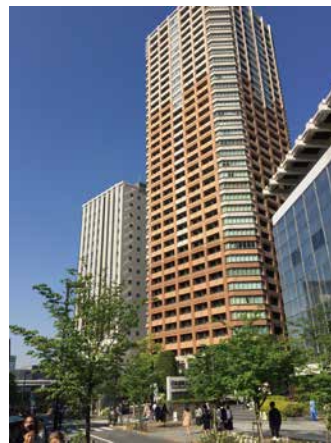
千代田区・富士見二丁目北部地区 飯田橋プラーノ
