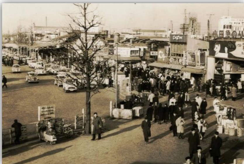
開発前の新宿駅西口（小田急線入口付近）（昭和 34 年頃）
