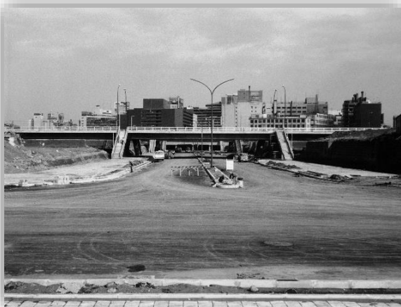
建設中の道路（昭和 43 年）
