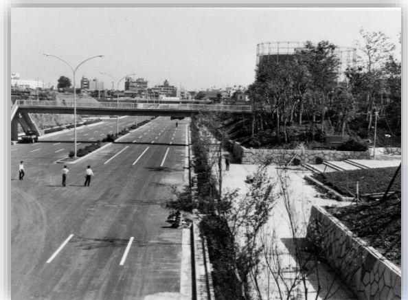
正面広場前の道路（昭和 43 年）
