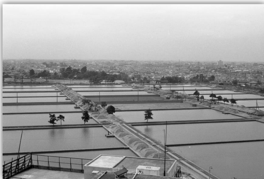
淀橋浄水場（昭和39年）
