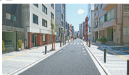
無電柱化の整備をした道路
