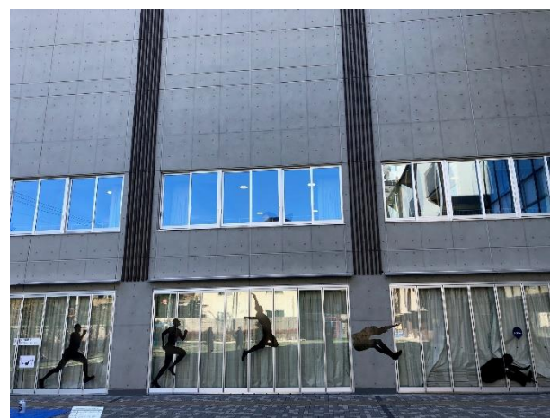
愛日小学校校舎外壁 走り幅跳び（オリンピック種目）
