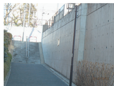
▲擁壁の耐震化の例
