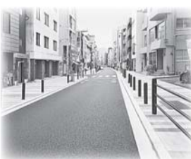
▲道路の無電柱化
