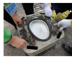
鉄板を外しねじを取る（4個）
