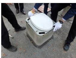
便座を裏返し、ねじを締めて（4個）固定する
