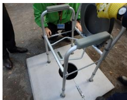
床板を敷き、仮設トイレを組み立てる
