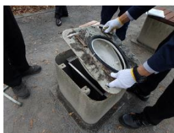
便座を裏返し、ねじを締めて（4個）固定する
