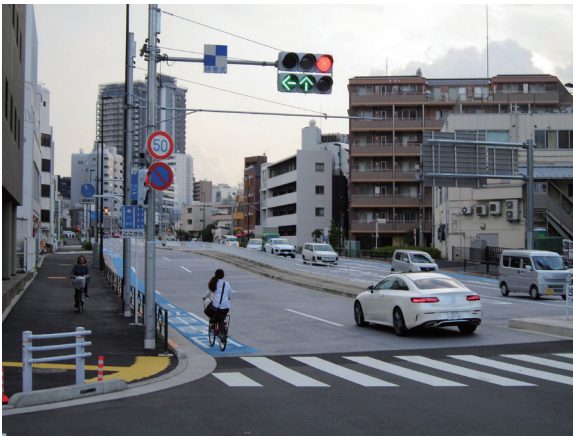
都市計画道路の整備の事例 (放射第25号線沿道：津久戸町～新小川町間)
