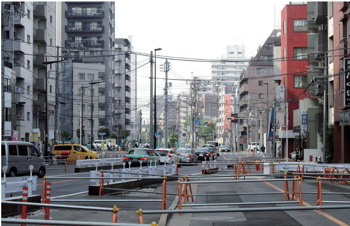
整備が進む環状第3号線(外苑東通り)
