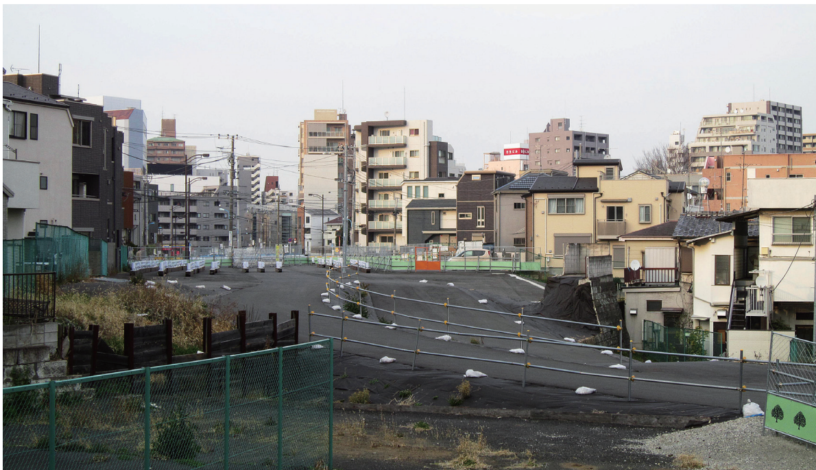
整備が進む環状第4号線
