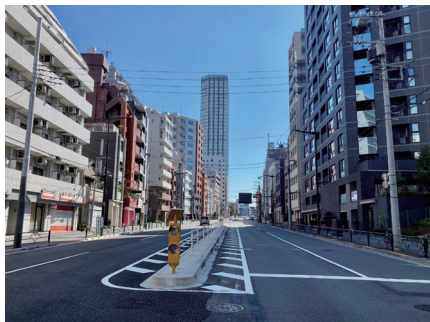
幹線道路沿いの集合住宅（外苑東通り）
