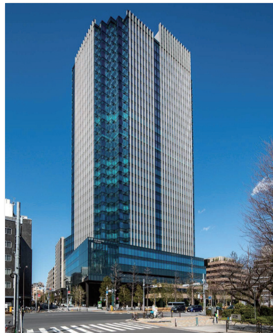
竣工写真 (撮影：㈱エスエス東京支店)
