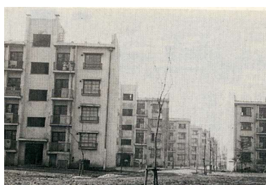
戸山アパート (昭和24(1949)年竣工)
