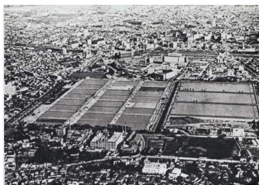
淀橋浄水場(昭和36(1961)年)
