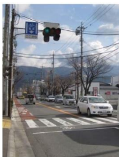
写真Ⅱ-6 道路標識「専用通行帯 (327の4)」と道路標示「専用通行帯 (109の6)」を設置した事例
