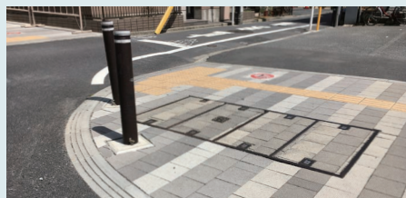
段差が解消された道
