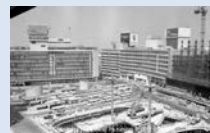
駅ビルと駅前広場が建設される西口（1966年）
