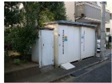
公園内の災害対応施設例 (南複公園)
