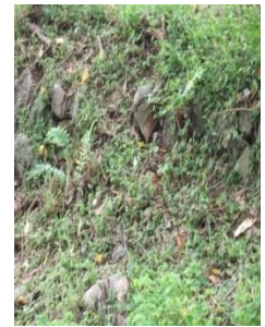
がけ・擁壁 (弱み)
