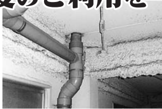
梁や天井に付着したアスベスト
