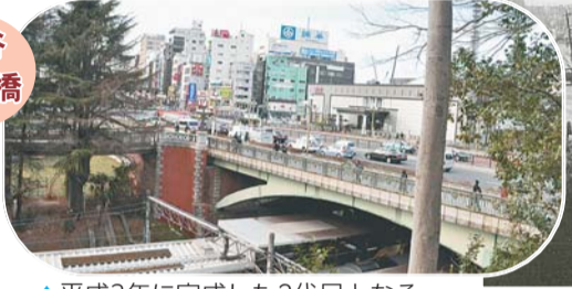
▲平成3年に完成した2代目となる現在の四谷見附橋
