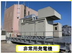
既存の非常用発電機を更新し、稼働時 間を向上(連続72時間)、緊急用汚水槽 を設置することにより、災害時に下水道 が分断されても、一部のトイレが使用可 能になり防災機能の強化を図りました。
