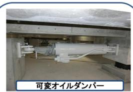
油の粘性を利用し地震の揺れを抑えます。 地震の規模に応じて、揺れを抑える力を 変化させ、建物の変形を小さくします。
