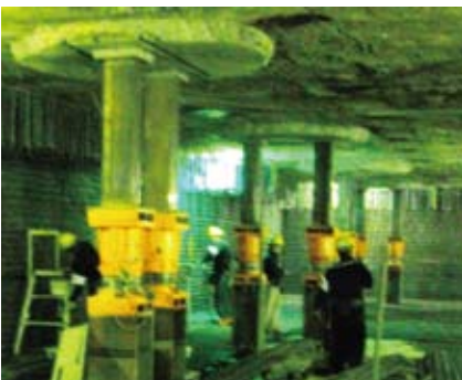
免震化が進む区役所本庁舎地下の様子
