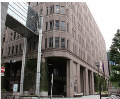
早急に本庁舎の耐震補強工事を！
