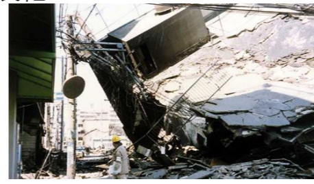
阪神・淡路大震災での被害 写真：(財)消防科学総合センター
