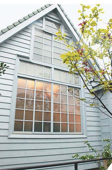
▲アトリエ棟の採光窓
