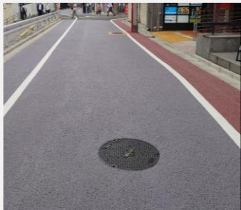
遮熱性舗装整備
