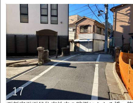
17 西新宿五丁目住宅地内の暗渠にかかる橋、笹塚から神田川につながる支流の暗渠には橋が残されており、日常の風景として残されている。
