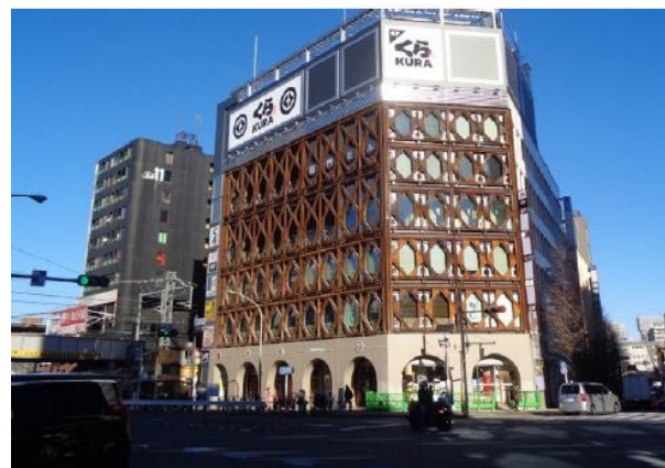
緊急輸送道路沿道建築物の耐震改修事例
