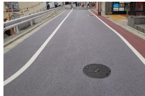
遮熱性舗装整備
