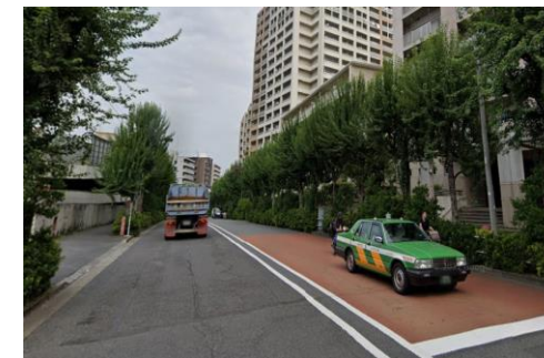
自転車通行空間 施工前（小滝橋通り）
