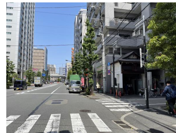
江戸川橋通り改良工事（工事前）
