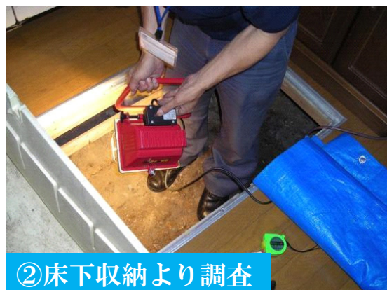
図2-5 床下収納からの目視調査
