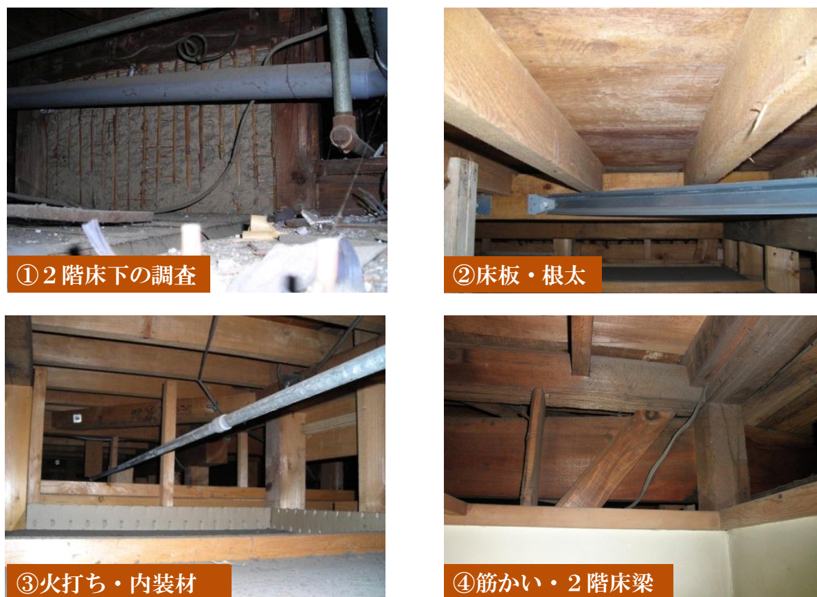
図2-4 2階床下の調査
