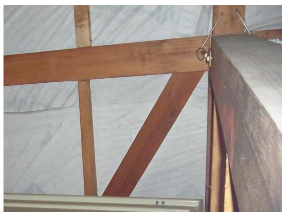
図3-2 釘打ち(びんた延ばし)
