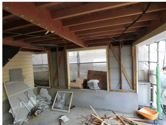
図3-15 補強工事の様子
