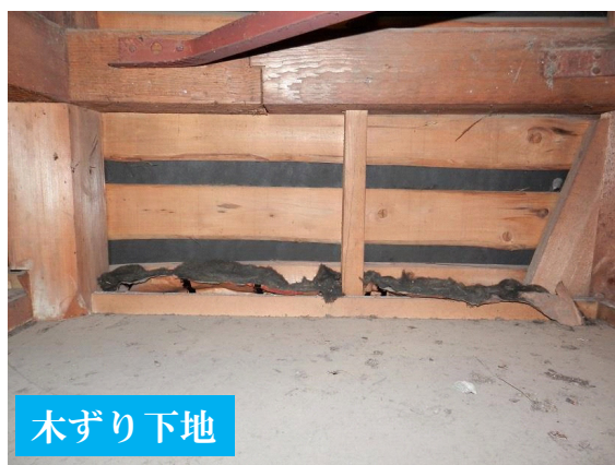
図1-15 ラスモルタル塗りの木ずり下地とラスシート下地
