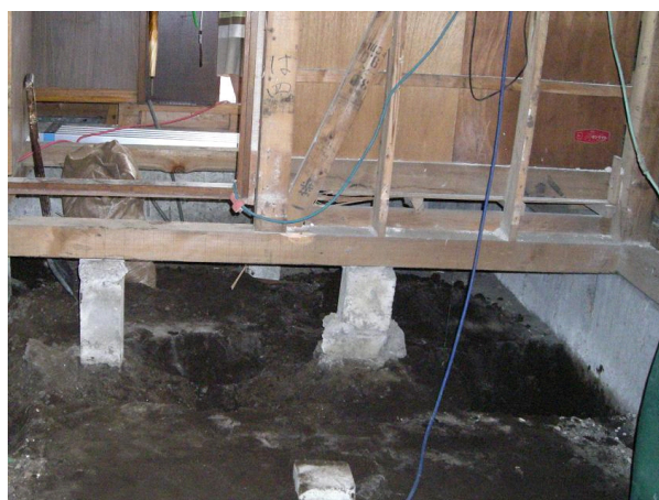
図1-24 布基礎のない筋かい壁
