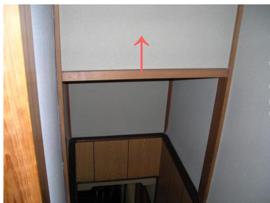
図1-12 階段部分の2階壁下部欠き込み
