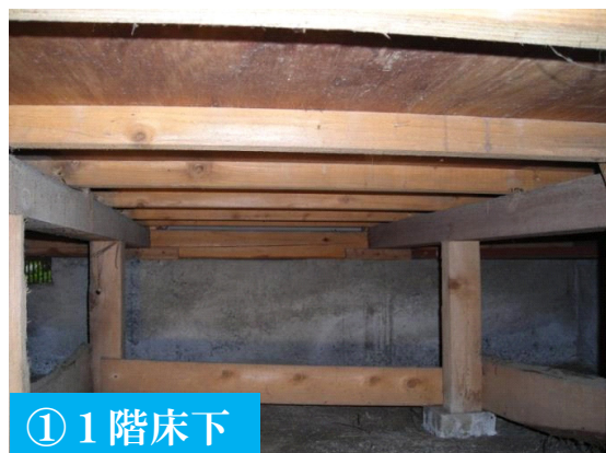
図2-5 床下収納からの目視調査
