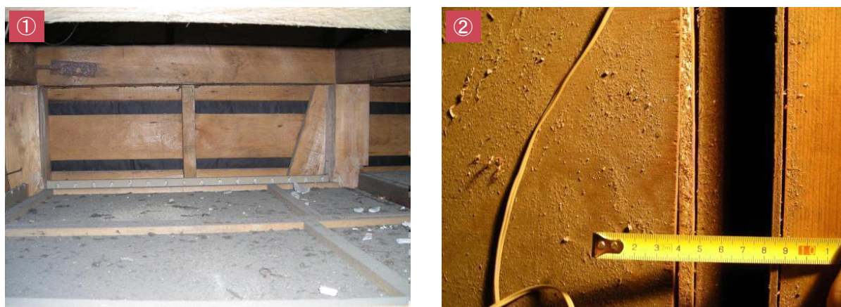
図2-3 天袋からの目視調査(2階床下)
