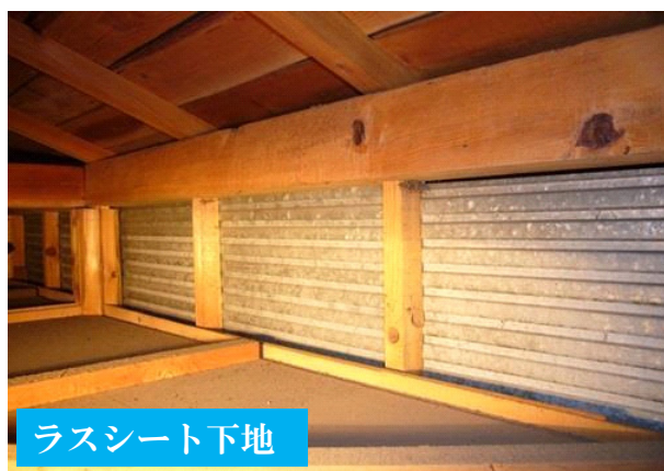
図1-15 ラスモルタル塗りの木ずり下地とラスシート下地
