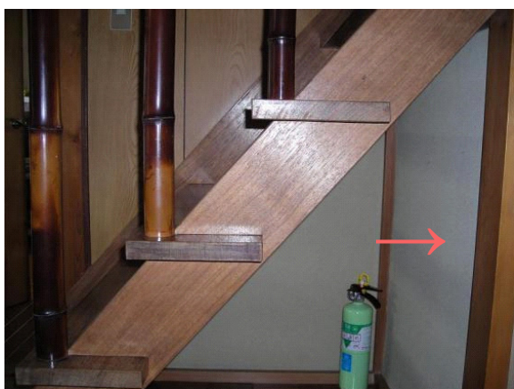
図1-11 階段下の高さ不足の不十分な壁
