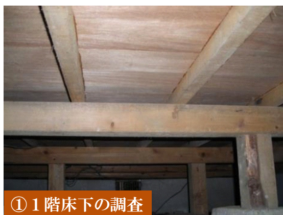
図2-5 床下収納からの目視調査
