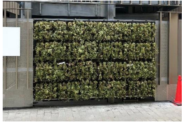
▲道路に面した壁面緑化
